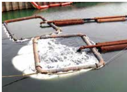
浚渫土砂排出状況
