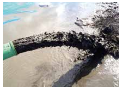
泥土排出状況
