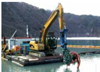
ダム堆積泥土の浚渫状況
