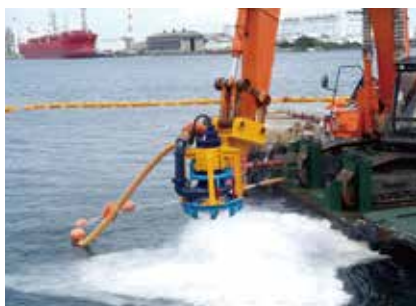
港湾岸壁部の堆積物除去状況
