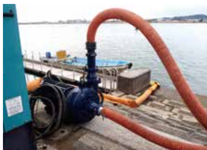
取水口周辺の堆積物浚渫状況
