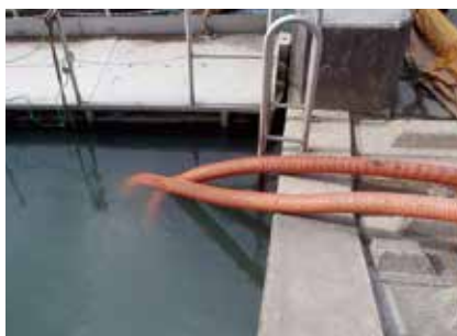
潜水士による水中での浚渫作業状況
