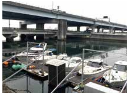
船舶係留部や航路の堆積泥土除去
