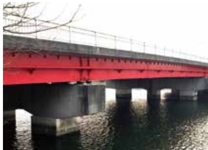
栈橋や橋梁の下部
