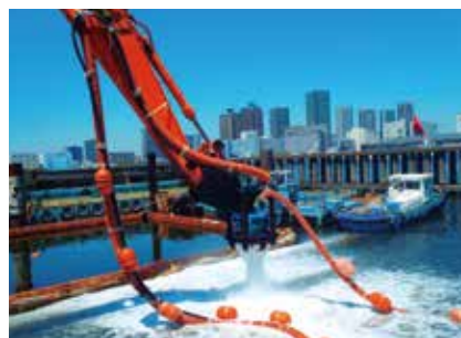
船舶係留部の堆積泥土を浚渫
