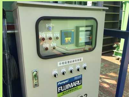
操作簡易な処理装置制御盤 PH指示計×1、放流PH記録計×1
