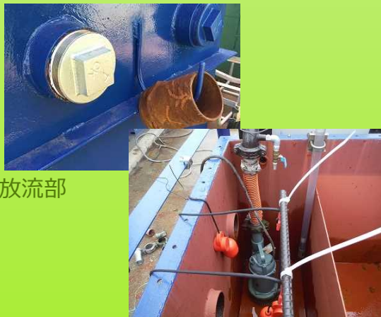
放流部は水中ポンプ方式 もしくは4インチホースケノによる自然 放流方式
