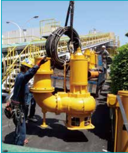
仮設排水ポンプ／設置工事
