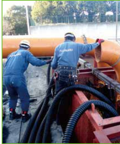
仮設配管材料／配管工事
