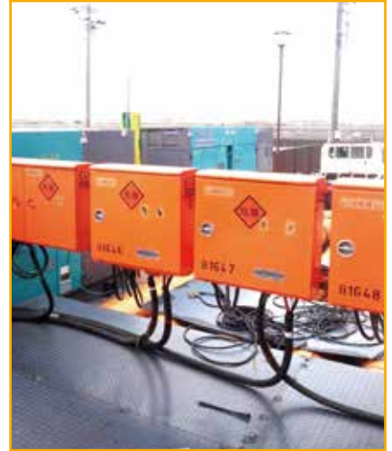
仮設発電機／配線工事
