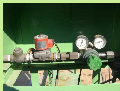
炭酸ガス圧力調整弁
