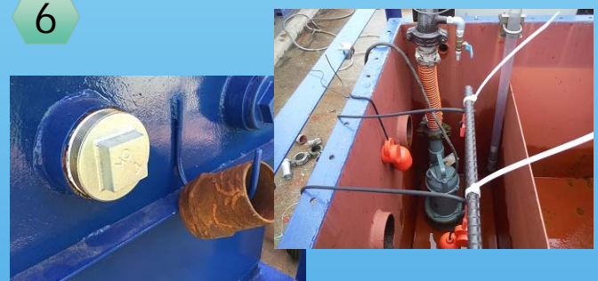
放流部 放流部は水中ポンプ方式 もしくは4インチホースタケノコによる 自然放流方式
