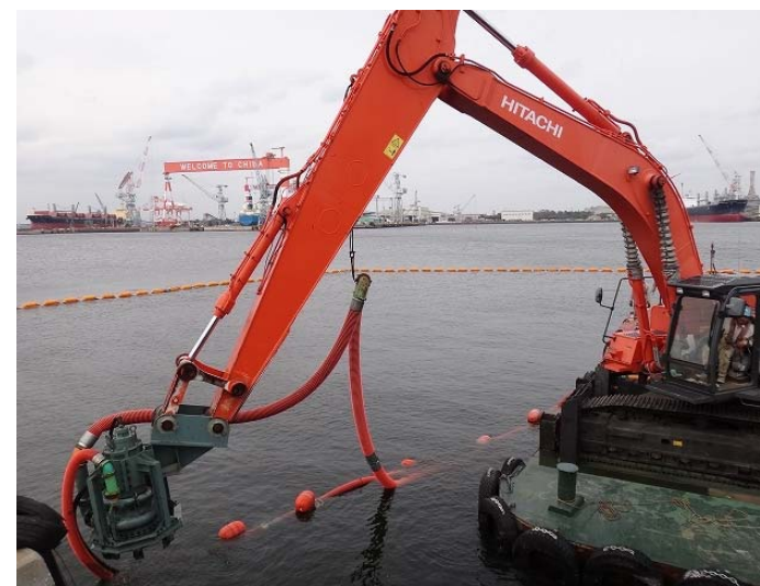
堆積泥土浚渫状況
