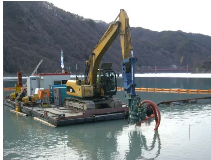
堆積泥土浚渫状況
